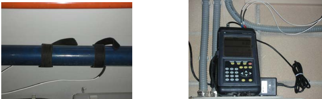
Figura 22. Instalación de caudalímetro en tubería.
